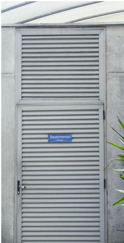
Área externa de recebimento
