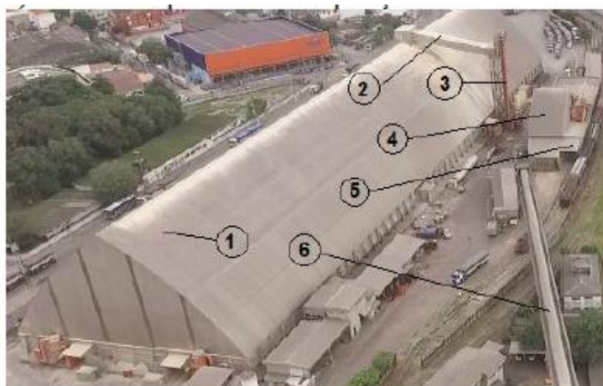
Figura 1: Fluxograma simplificado da recepção de grãos do Terminal XXXIX de Santos. 1) armazém graneleiro; 2) correia transportadora de recepção; 3) elevador de caçambas; 4) moega de descarga de caminhões; 5) moega de descarga de vagões; 6) correia transportadora de expedição.
