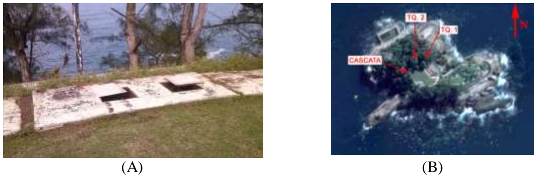
Figura 3. (A) Aspecto dos Reservatórios de água pluvial sob o solo argiloso da ilha. (B) Localização relativa dos reservatórios em relação à Ilha.
