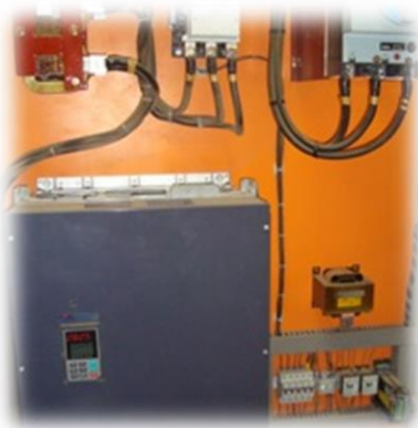
Figura 2. Painel do Drive Inversor de Frequência 440V. Fonte: [10]
