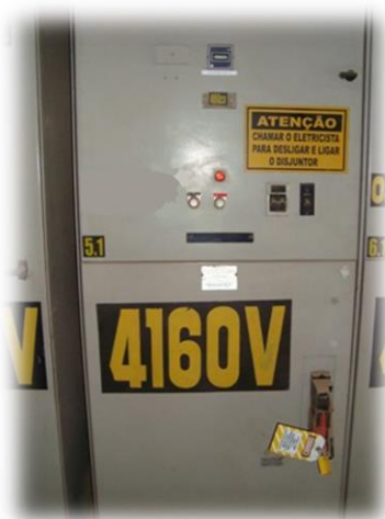
Figura 1. Painel da Chave de Partida Direta 4160 v. Fonte: [10]
